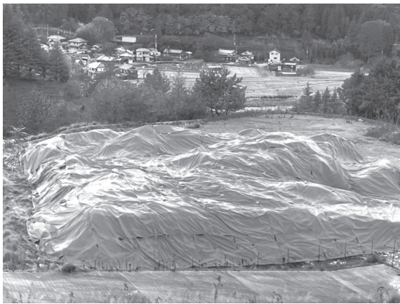
飛散防止のためのビニールシートで養生
