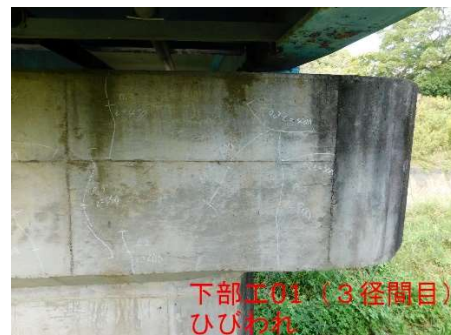
下部工にひびわれが見られます
