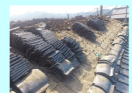
土葺き瓦屋根
