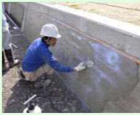
水路壁の表面被覆
