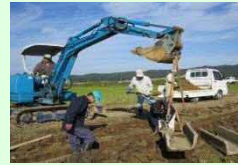
コンクリート水路の更新
