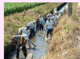
水路の泥上げ
