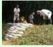
漏水箇所の補修
