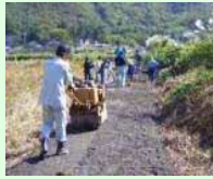
未舗装農道の舗装
