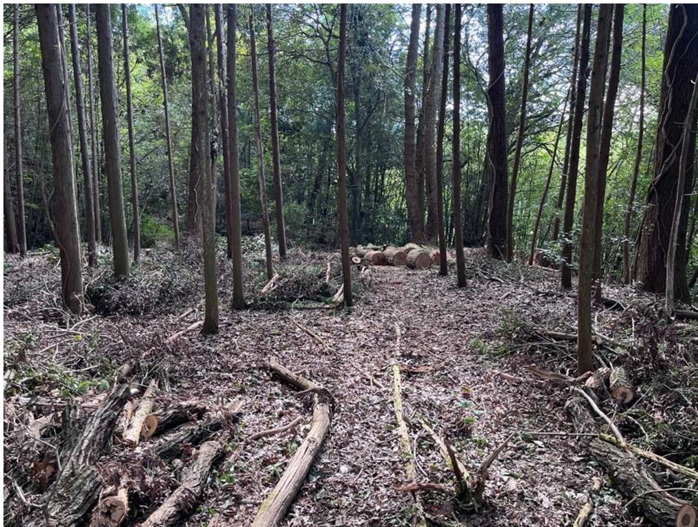
危険・支障木の伐採
