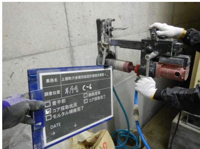
図 3-1 コンクリートコア採取状況
