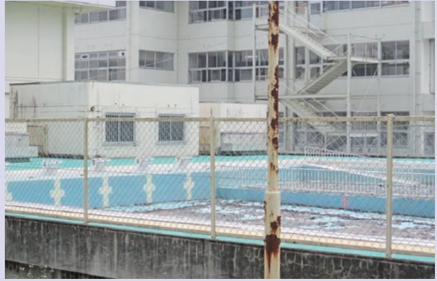
▲解体する山野里小学校プール
