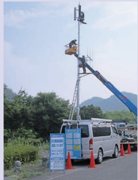
▲防災行政無線の整備風景
