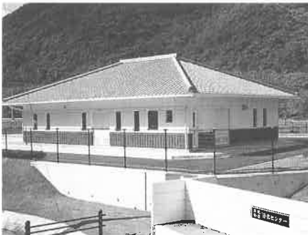
完成した落地・梨ヶ原浄化センター
