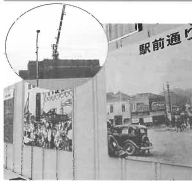
防護壁に設置された写真パネル (円内は建築中の町営住宅)
