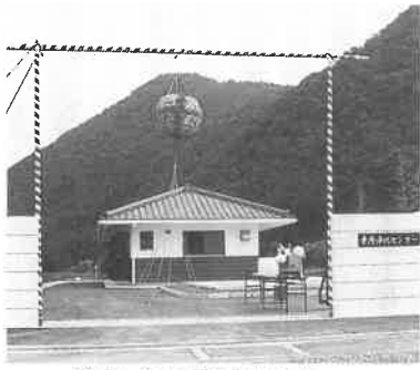
完成した栗原浄化センター
