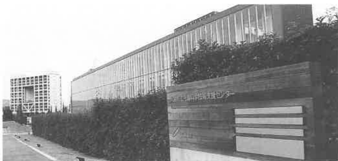
完成した先端科学技術支援センター第2期施設
