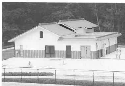
岩木浄化センター
