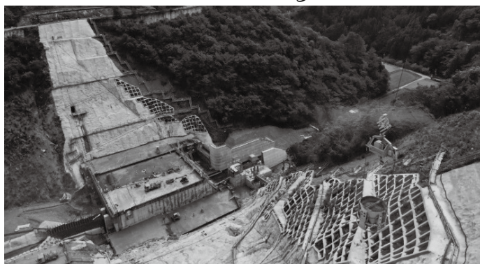
堤体工事写真
