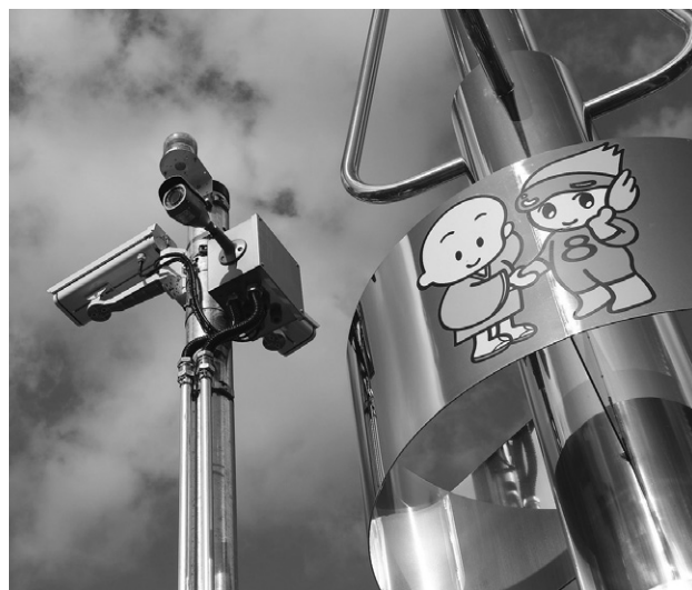
駅前広場に設置された防犯カメラ
