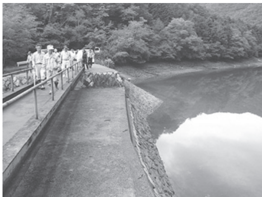
ため池のパトロールの様子
