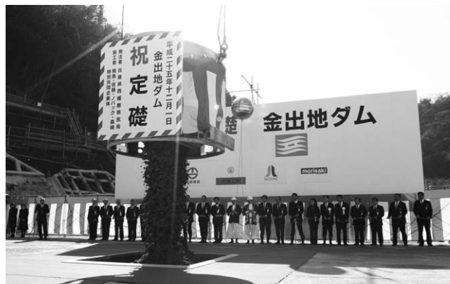
↑礎石の上にコンクリートが投入され、固められました
