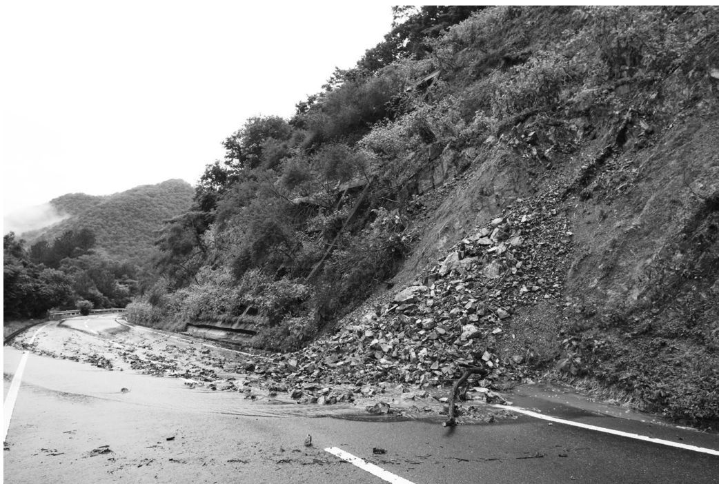
↑平成24年7月7日の大雨による土砂崩れ
