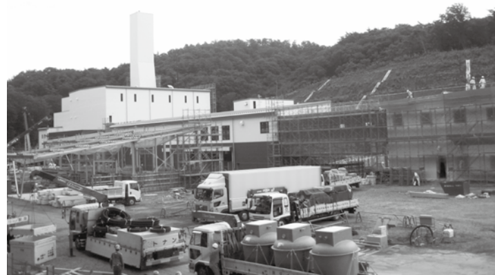
↑ 工事が進む「にしはりまクリーンセンター」(平成24年8月末現在)
