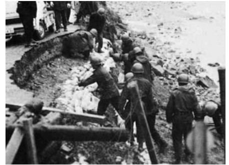
←自衛隊による復旧作業
