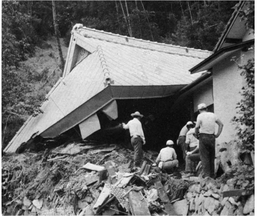
↑昭和49年台風8号で、裏山が崩れ倒壊した家屋（正福寺）
