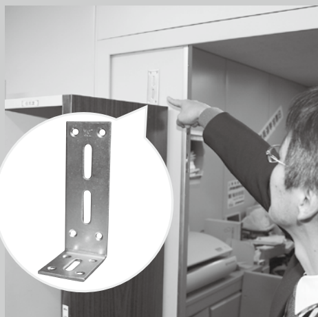
転倒防止器具の取り付け例
