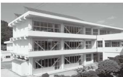
耐震補強が完了した山野里小学校
