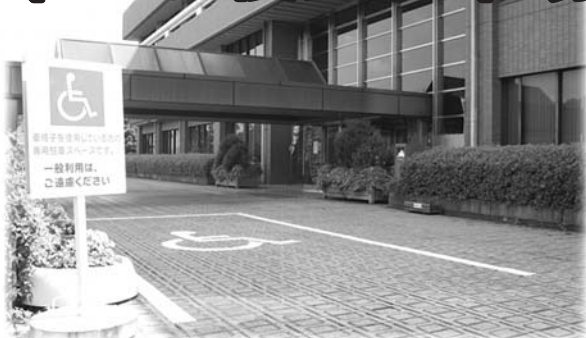
役場正面玄関に整備された優先駐車場
