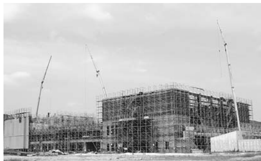
建設中の上郡中学校
