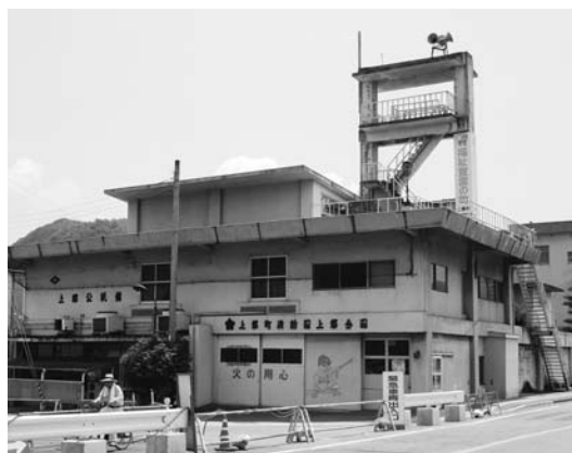
解体される上郡公民館
