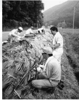
県道へのセンチピートグラス(芝生)の植栽
