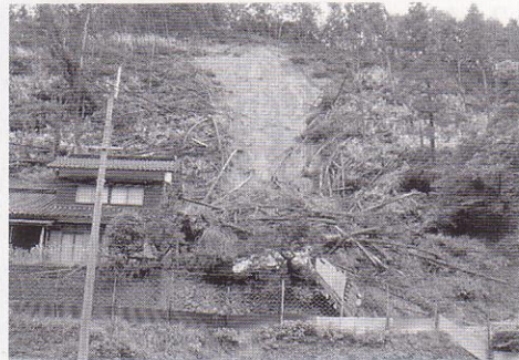
7月に佐用町で発生した土砂崩れ
