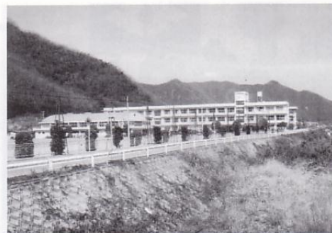
移転についての協議が始まった「上郡中学校」
