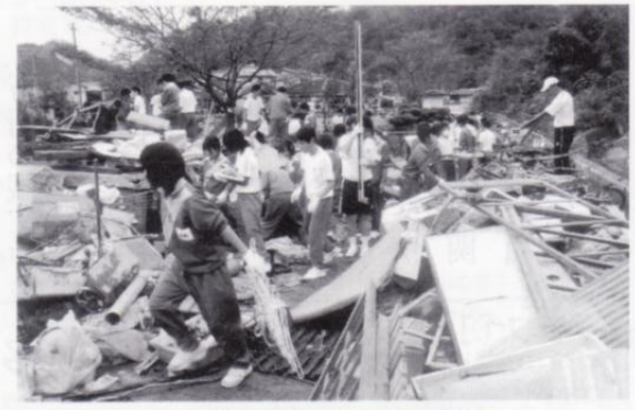
台風21号後の災害復旧作業(昨年10月)
