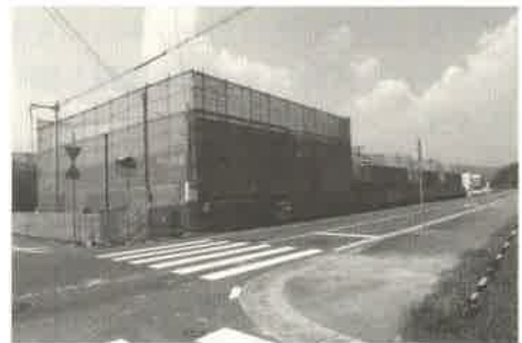
▲ 高田幼稚園耐震工事
