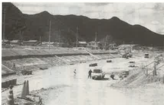
河川改修工事中 (旧上郡中学校跡)
