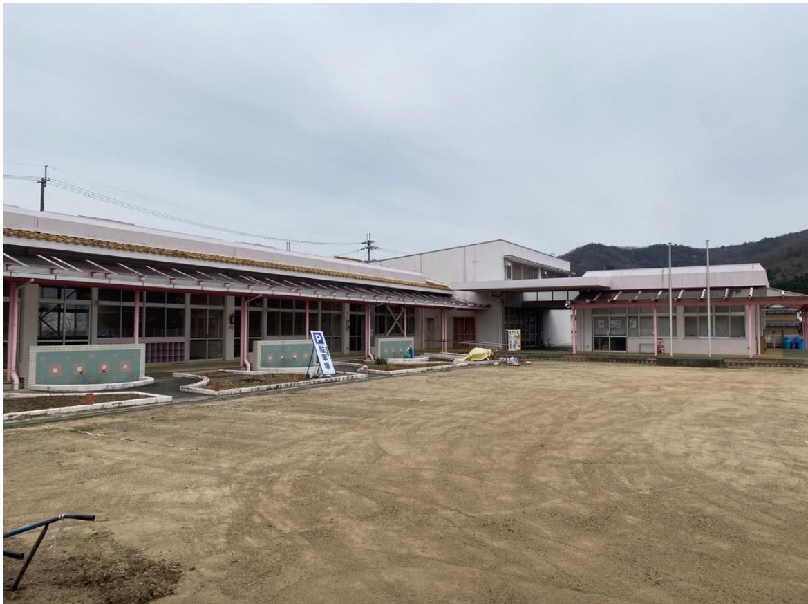
建物外観（南西から）
