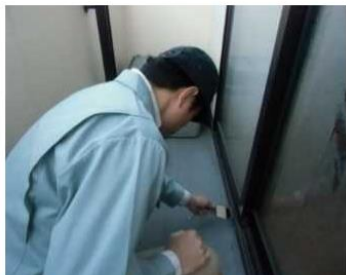
「外部（バルコニー）」調査の様子
