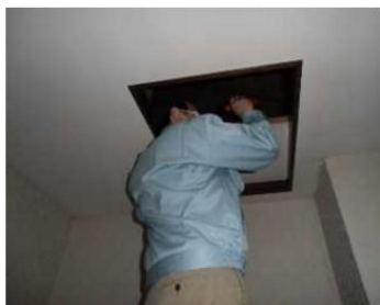
「小屋組・梁」調査の様子
