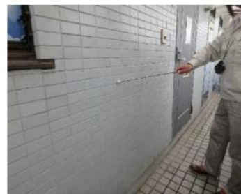
「外部（外壁）」調査の様子
