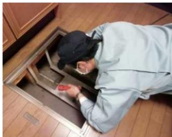
「土台・床組、基礎」調査の様子
