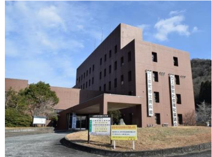
建築から47年が経過する第3庁舎
