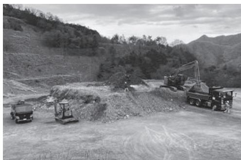
撤去作業の様子
