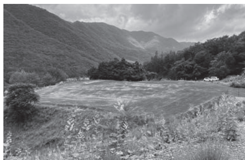
撤去完了後の状況
