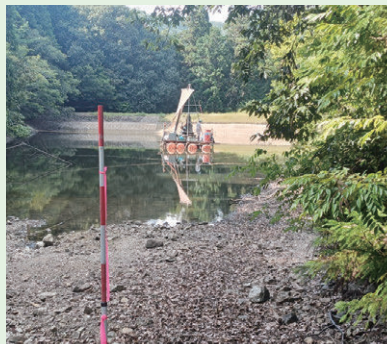
▲上流（南側）からの論気下池、池底ボーリングの状況
