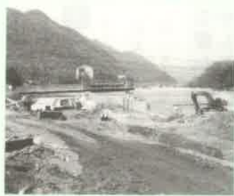
建設中の大持井堰
