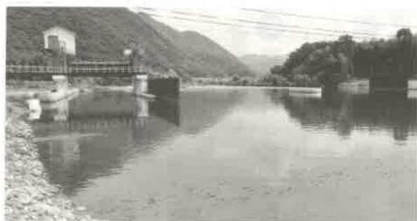
▲ 河川改修（大持井堰）
