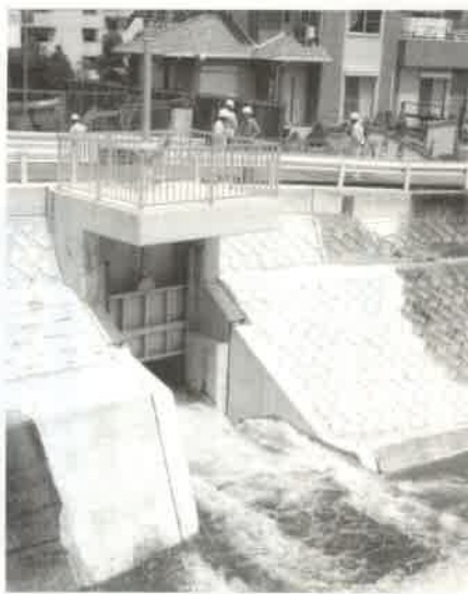
駅西ポンプ場視察
