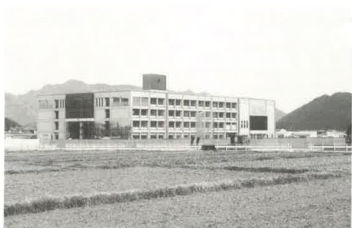
▲ 竣工を待つ 上郡中学校
