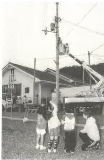
▶ 光ファイバー架設中
