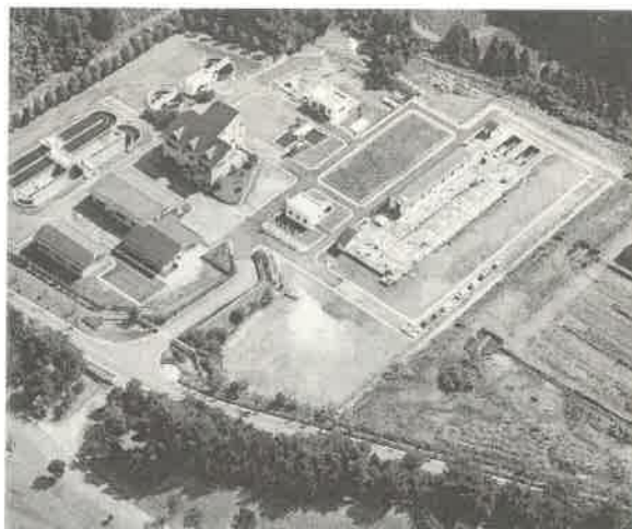
播磨高原浄化センター全景
