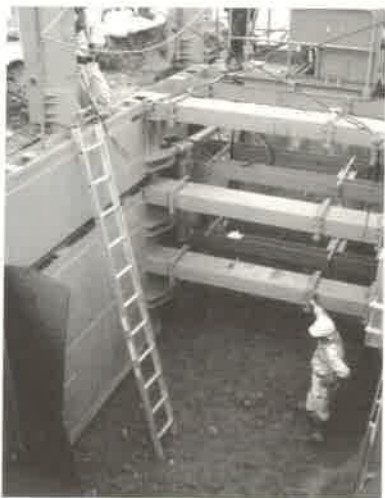
雨水幹線工事
