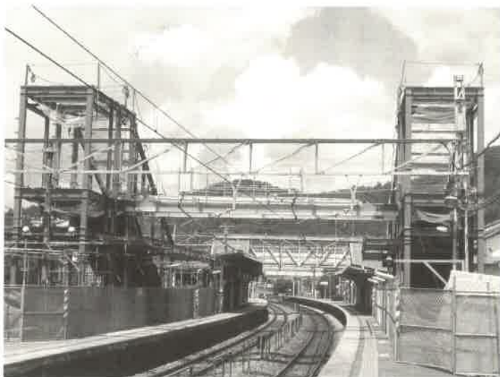
▲ 上郡駅 バリアフリー化工事
