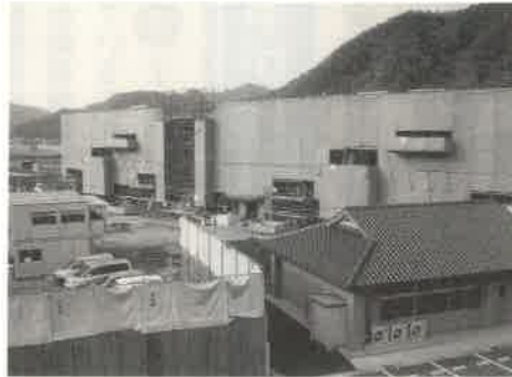
遅れている二期工事
