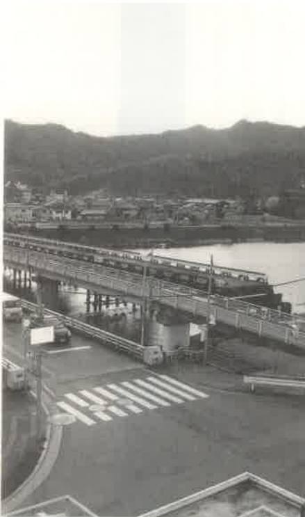
上郡大橋の仮橋
