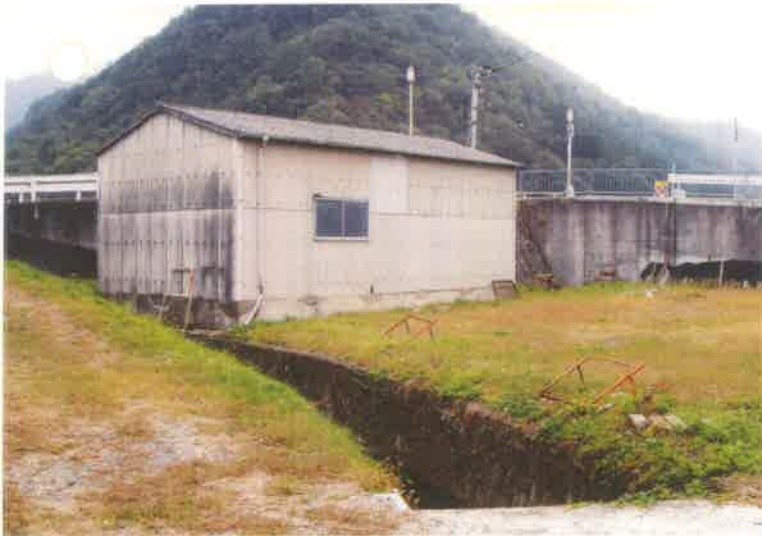
駅西ポンプ場建設予定地
