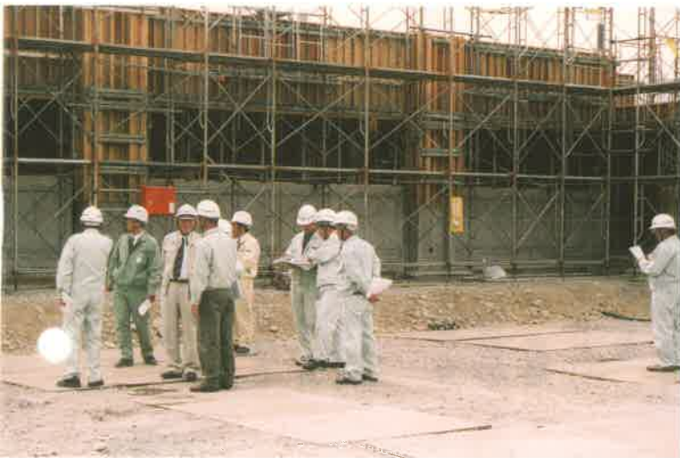
▲町営住宅工事現場
