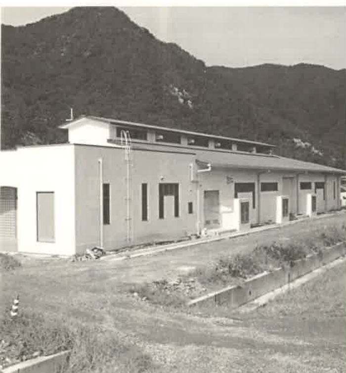
大枝新浄水施設建屋完成
