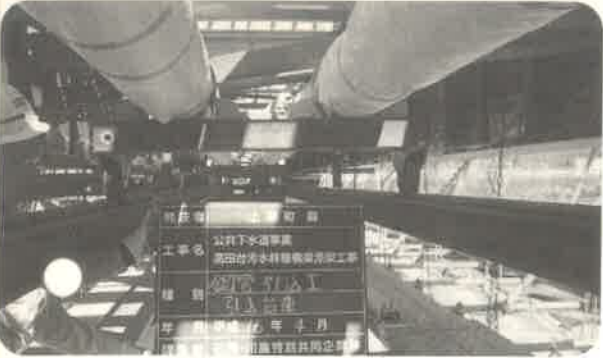
▲下水管添架工事（あゆみ橋）
