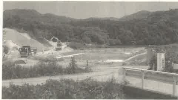
▲墓園造成工事
